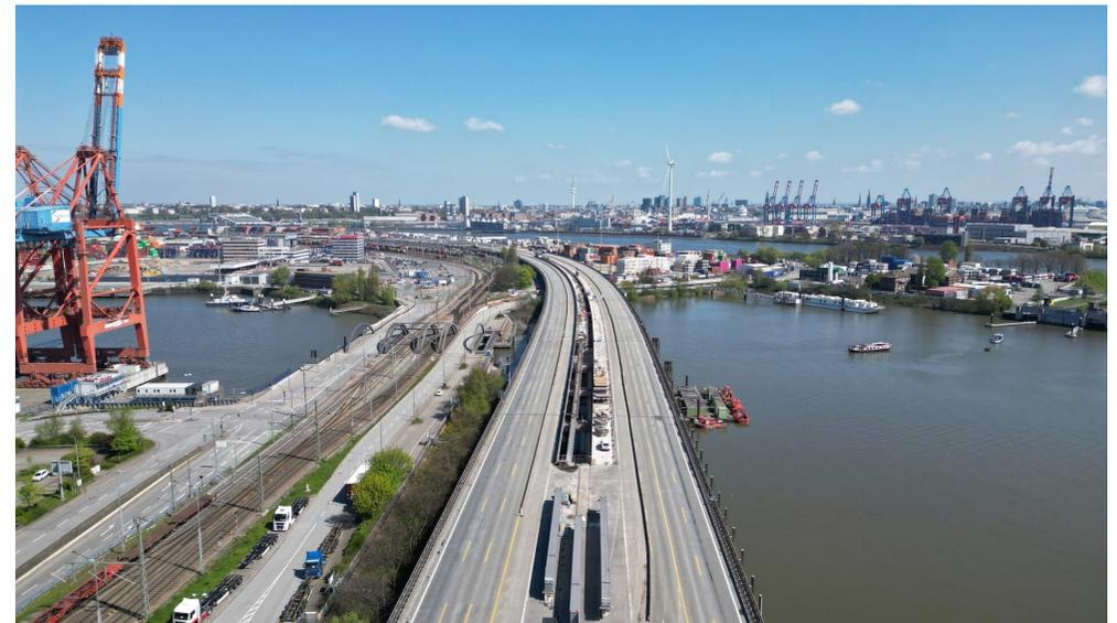
Hochstraße Elbmarsch K20, Überbauerweiterung durch Quervorspannung mit Koppelstellen
